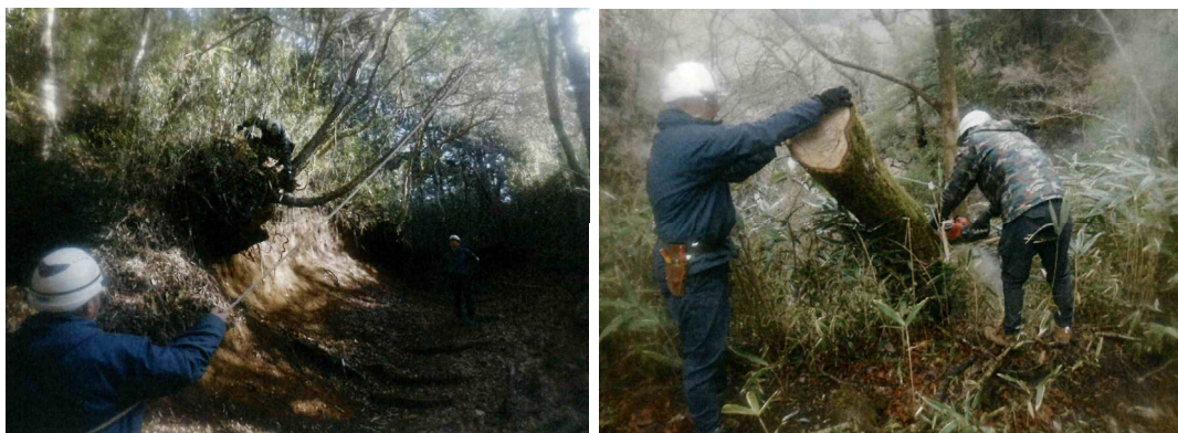
枯損木の伐倒整理 撮影
