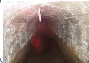
《2号トンネル(未施工箇所50.3m)》
