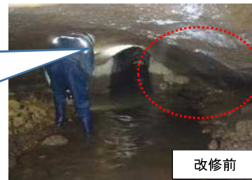
2号トンネル L=166.8m
