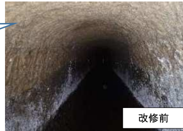
1号トンネル L=177.5m
