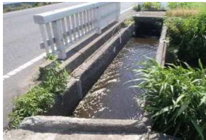
《新川排水路掛樋(水路橋)》
