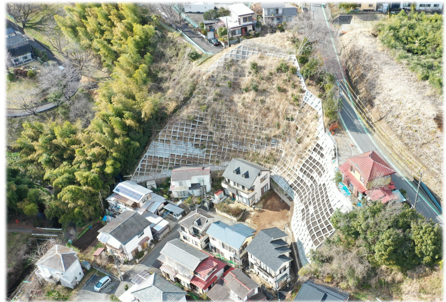
（急傾斜地崩壊危険区域 根小屋B地区）
