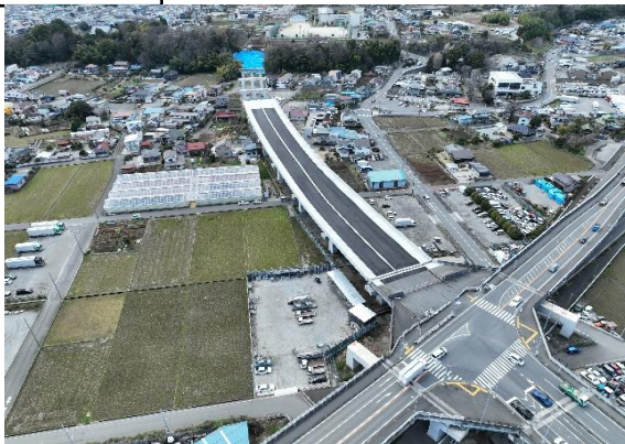
高架工区 (R6.3撮影)
