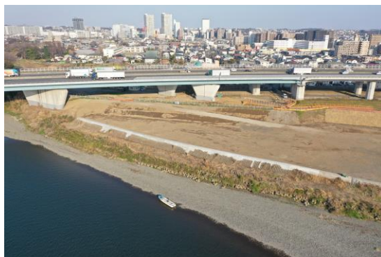
高水敷掘削工施工後
