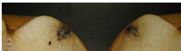
穿孔部の切断写真（穿孔部が黒変している）
