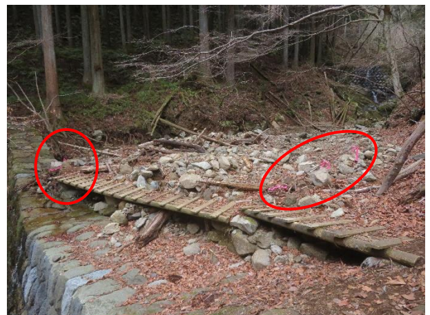
作業後（赤丸に目印を設置）
