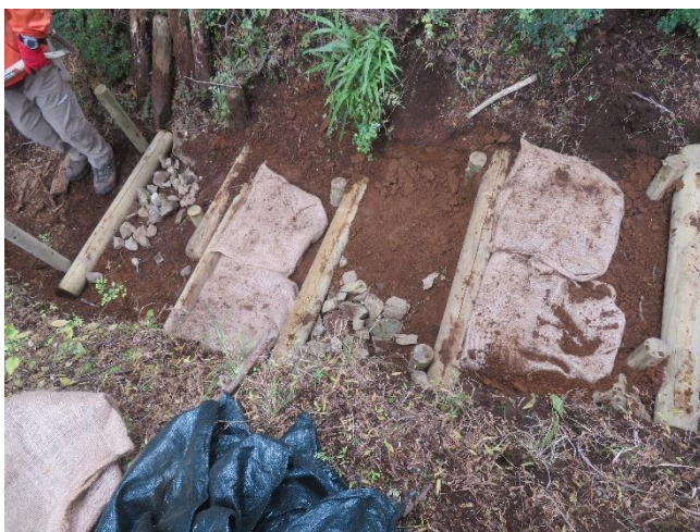
丸太の間に石と土嚢の設置
