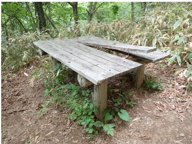
野外卓（補修前）
