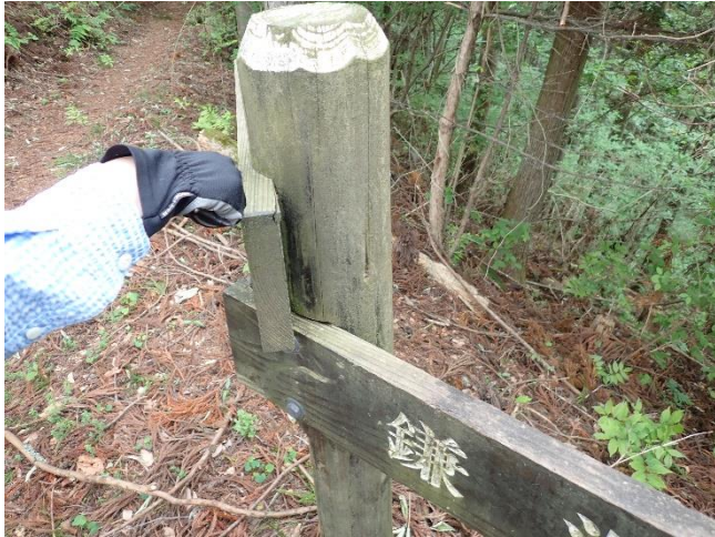
指導標識点検の様子
