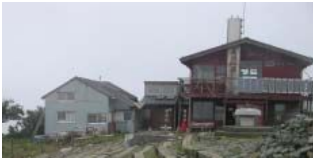
写真 3 塔ノ岳公衆トイレ
