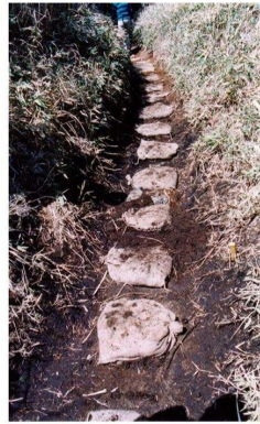
写真4 補修後の登山道
