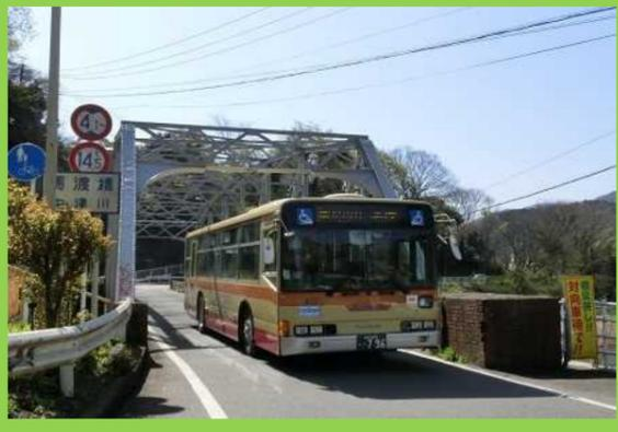
旧馬渡橋は、一級河川中津川に架かる延長約48mのトラス橋でした。大正15年の架橋から約90年が経過し、通行する車の荷重制限があり、道幅が狭く、車のすれ違いが困難な状況でした。
