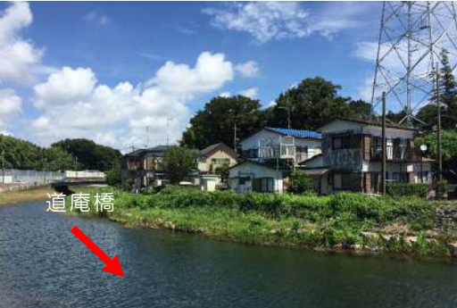
道庵橋下流の状況
