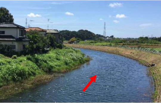
道庵橋下流の状況
