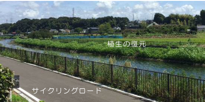
神崎橋～水管橋の状況
