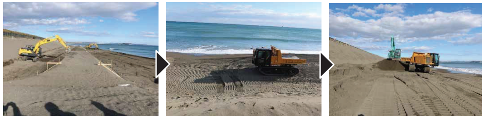
図4 サンドエンジン方式による養浜工事 （左：土砂量検収の盛土、中：養浜砂の運搬、右：重機によるクローラードンプへの積み込み）
