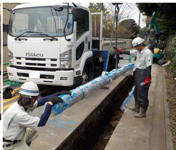
铸铁管の更新の様子
