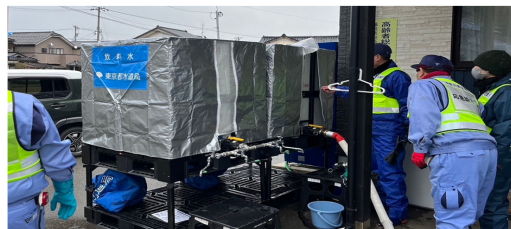
能登半島地震支援(仮設受水槽)
