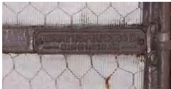
上：ドーム内観／昭和42年に復元されました 中：竣工当時のイギリス製スチールサッシ 下：県立歴史博物館外観
