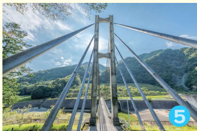
昭和54年度に土木学会田中賞を受賞し、かながわの橋100選にも選ばれている松ヶ山橋です。ダム管理用のコンクリート橋で、わが国初めての建設技法が使われたPC斜張橋として知られ、建設技術発展の一里家になりました。
