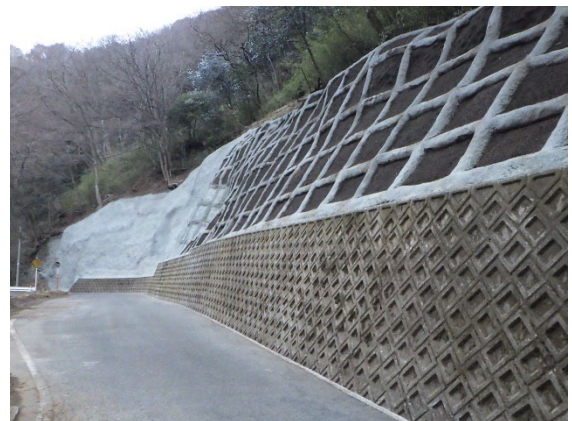
林道施設（法面保護工）
