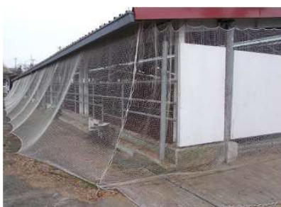
防鳥ネットの補修
