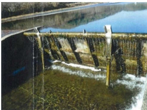
老朽化した頭首工の補修
