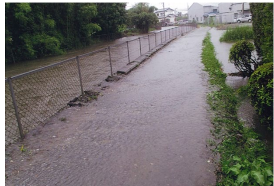
水路拡幅による周辺被害防止
