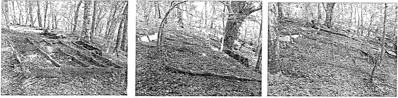
写真 2009 (H21) 年7月時点の対策工の状況
