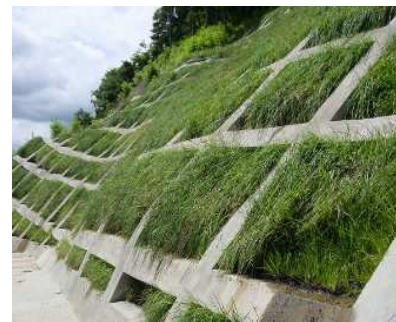
施工イメージ
