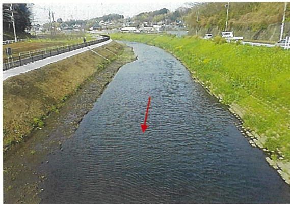
道庵橋上流(整備中)
