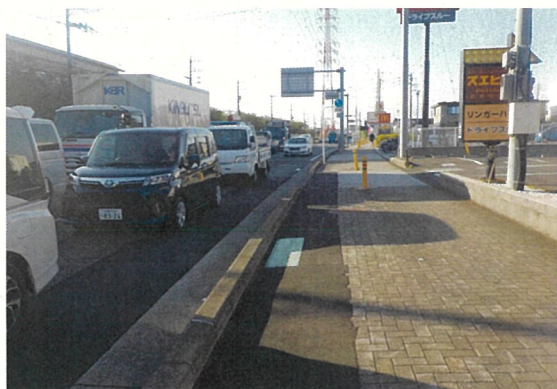
電線地中化整備状況
