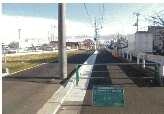
令和6年度歩道整備状況
