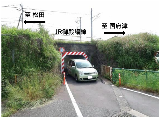
着工前の状況
