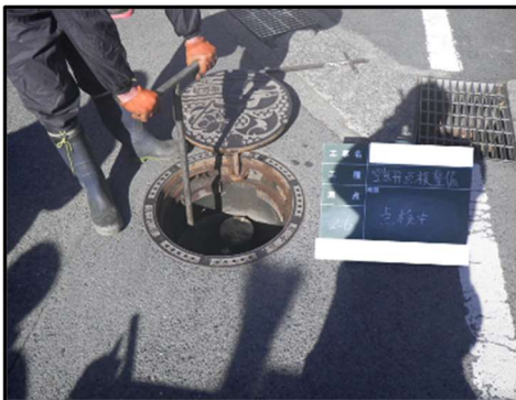
ボルトに緩みがないか点検している
