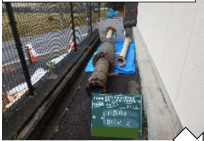
撤去したポンプ(水中ポンプ 55kW)
