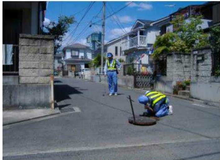
道路での漏水調査の様子
