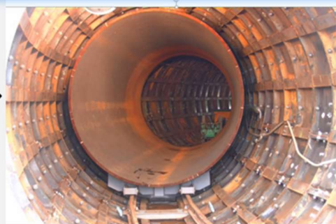
水道管を中に押し込む
