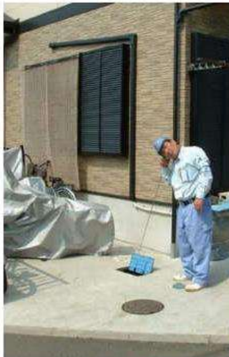
宅地内の漏水調査の様子
