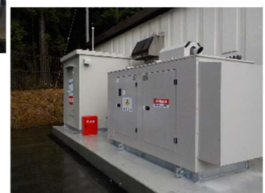
取水ポンプ所
