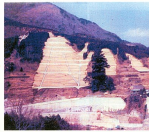
○山腹工施工状況（昭和49年）
