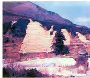
○山腹工施工状況（昭和49年）
