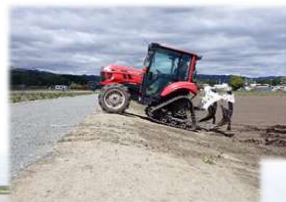
ターン農道の設置
