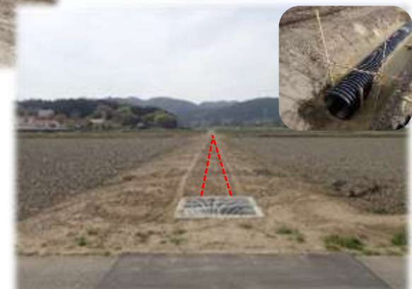
排水路の暗渠化
