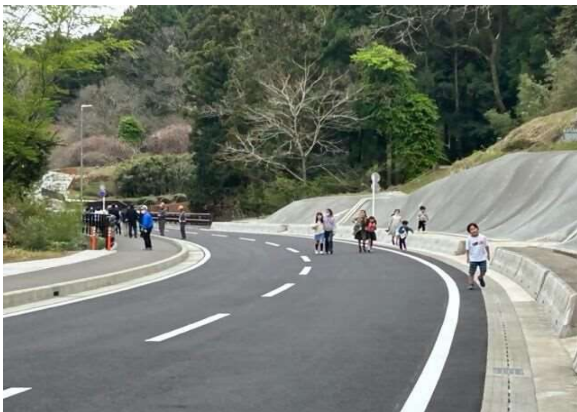
開通前の見学会の状況
