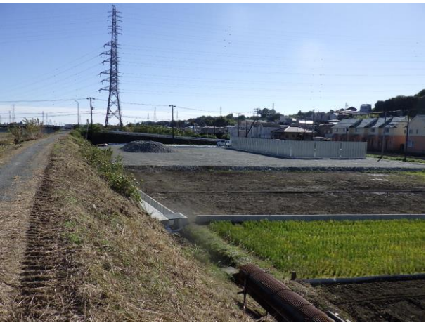
狩川下流側の右岸堤防から西側を望む
