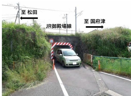
着工前の状況
