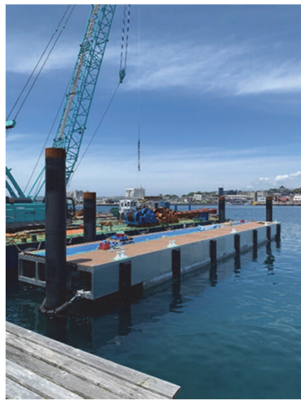
写真8 アルミデッキ組立後、鋼管杭に係留
