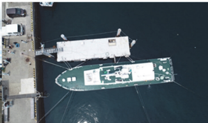
写真2 先代浮棧橋上空写真
