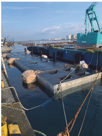
写真6 新浮棧橋コンクリート浮体
