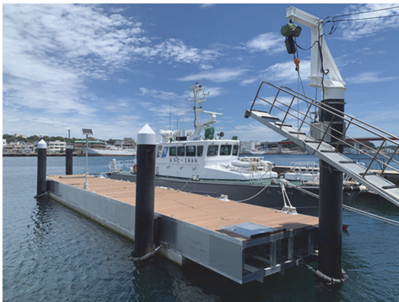
写真9 新浮棧橋竣工
