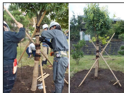
支柱施工実習
