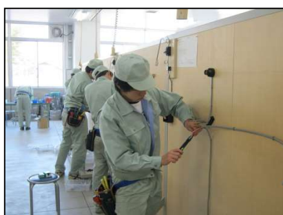
電気工事実習
