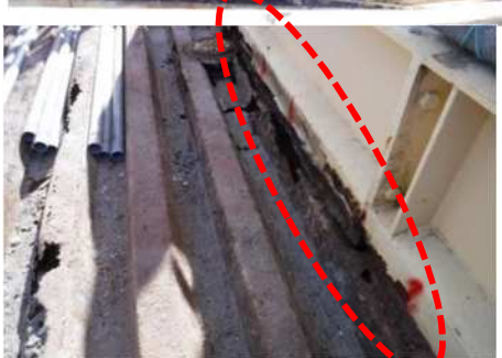
※ 舗装を除去した後の地覆の状態
