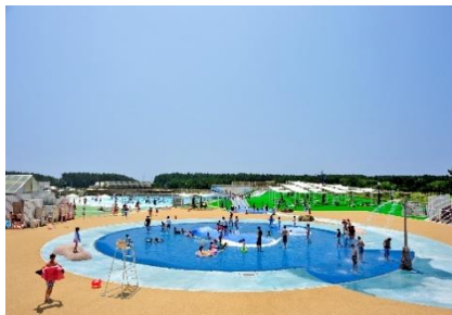
ジャンププール(くじらの海) (H27年7月完成)
