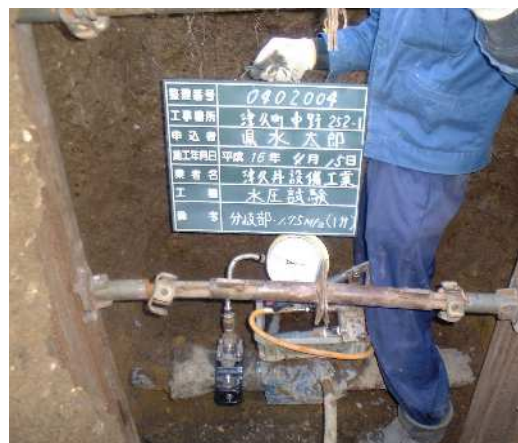
④ 水圧試験（分岐部）
