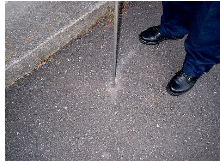
図 3-12 ボーリングバーでアスファルトに穴を開ける
