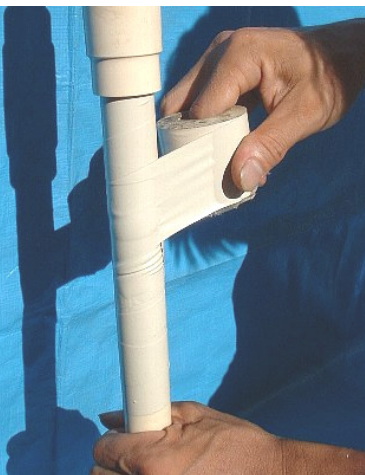
図 3-2 クリップの接続
