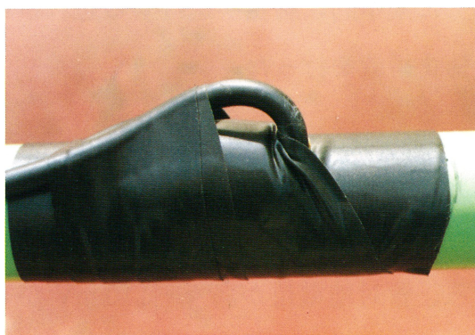
＜溶接部をベトマチックと防食テープで保護する＞
