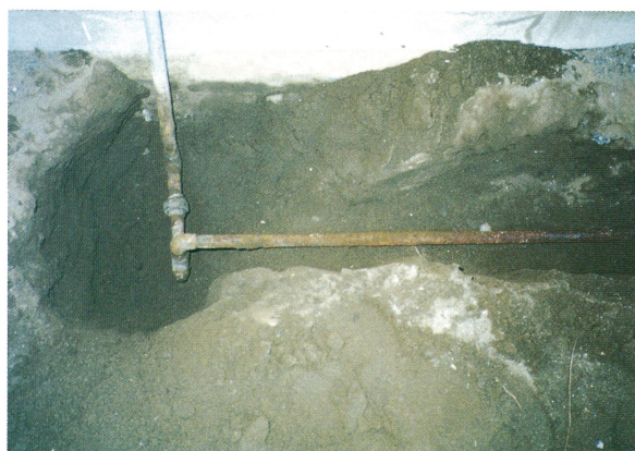
＜掘り出し状況＞
