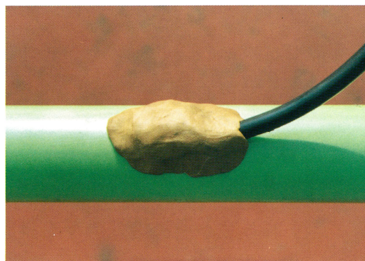
＜溶接部をベトマチックと防食テープで保護する＞
