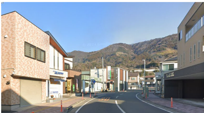
電線地中化工事（松田町内）
