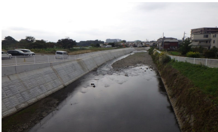
護岸整備工事（引地川（藤沢市内））
