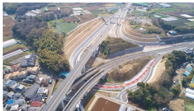
県道26号（横須賀三崎） [三浦縦貫道路Ⅱ期]
