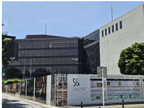
県民ホール本館 仮囲い設置工事
