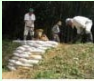
漏水箇所の補修
