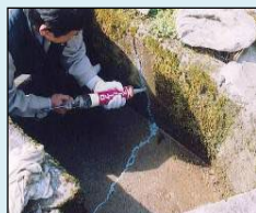
ひび割れの補修
