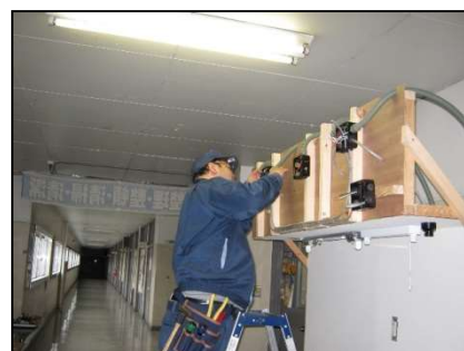
応用実習 (電気工事)
