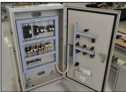
制御盤組立実習
