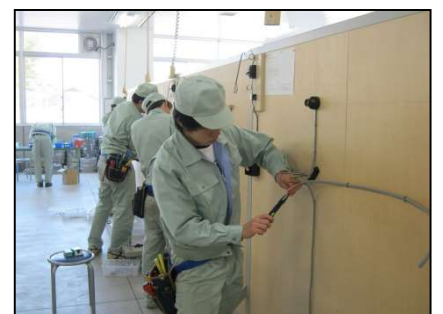
電気工事実習
