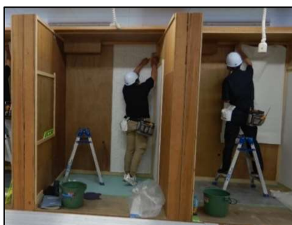
内装施工 (壁装)
