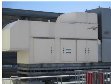
【ガスタービン発電装置・蓄電池設備】
