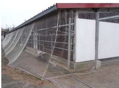
防鳥ネットの補修
