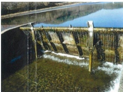
老朽化した頭首工の補修
