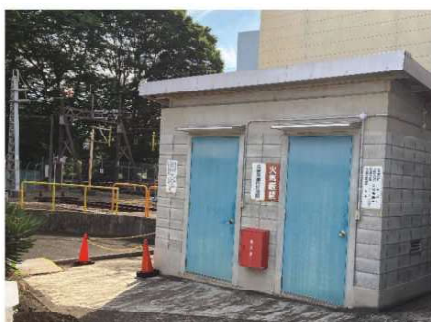
危険物屋内貯蔵所
