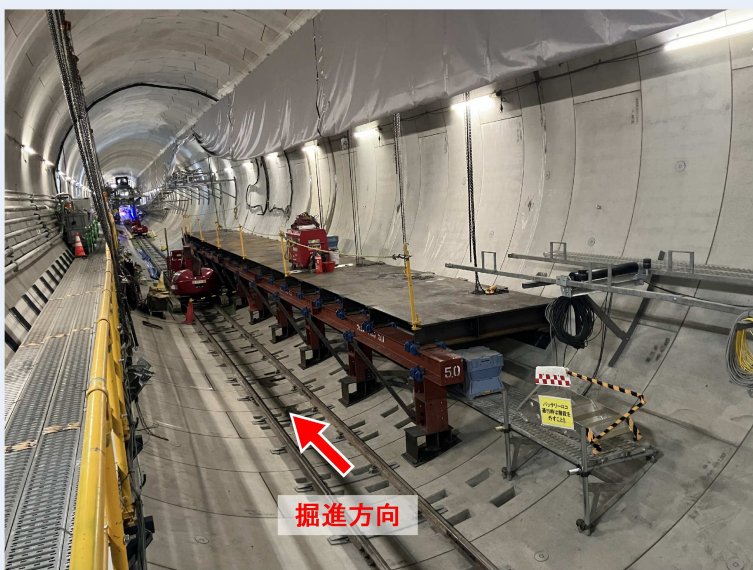
トンネル坑内(発進立坑から750m地点)
