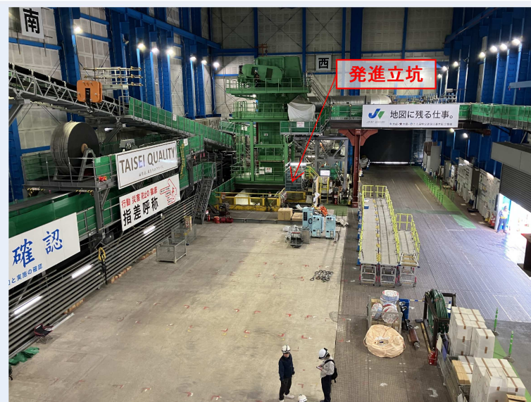
防音ハウス内部(発進立坑)
