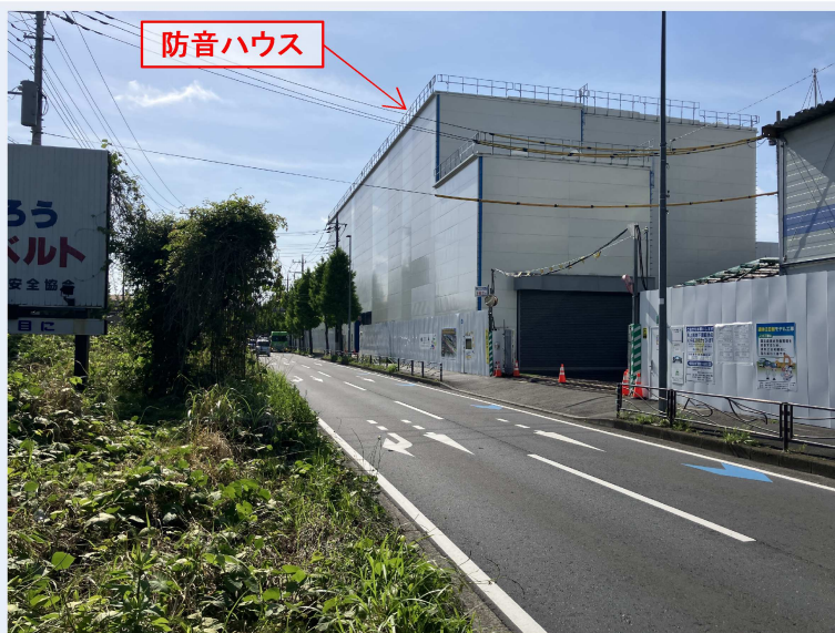
工事ヤード(防音ハウス)全景
