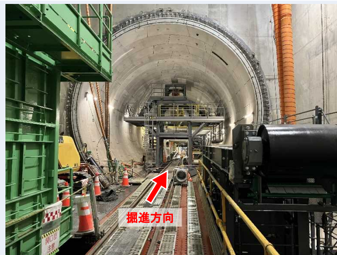
トンネル坑内
