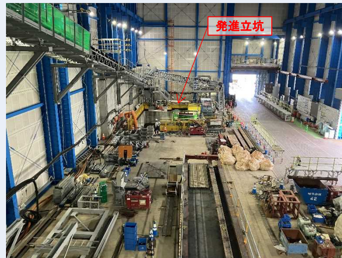
防音ハウス内部
