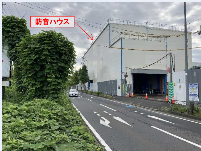
工事ヤード(防音ハウス)全景
