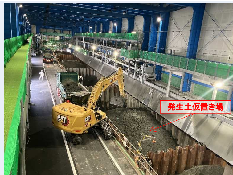
防音ハウス内部(発生土仮置き場)
