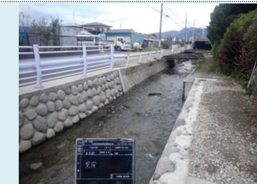
⑥河川・水路における自然浄化対策 自然石を用いた護岸整備を行い、湧水を遮断しないようにした。 (小田原市)
