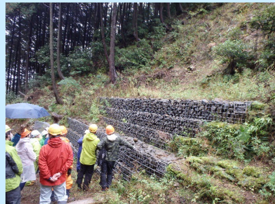
土壌保全対策の推進(厚木市) ＜現場視察＞
