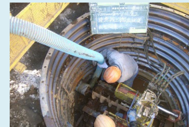
⑧生活排水処理施設の整備促進（下水道・浄化槽）道路を開削せず、トンネル状に掘削した穴に管を通す工法により下水道管を敷設した。 （相模原市緑区）
