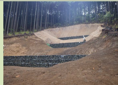
③ 土壌保全対策 水源林基盤整備事業では、土木的工法を用いて土壌保全対策を行った。（相模原市）
